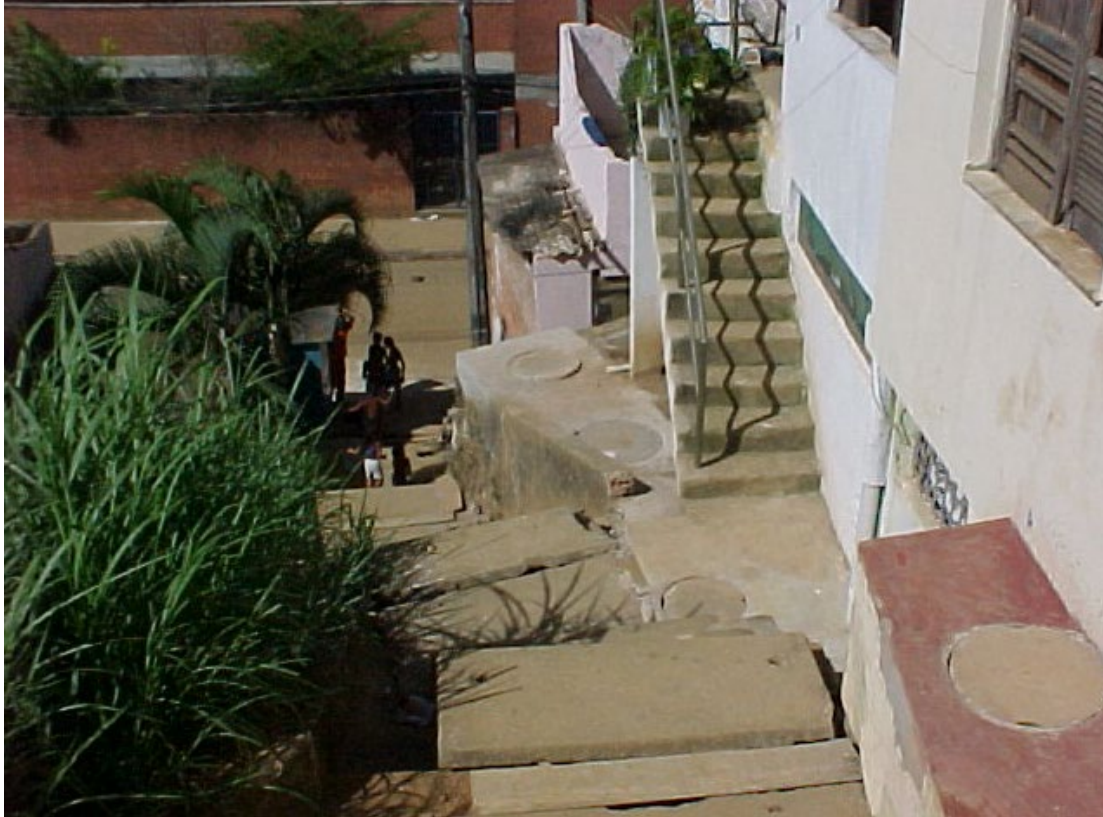
Figura 13: Rede condominial passando entre os imóveis e ao lado da escada de acesso aos imóveis, em bairro de Salvador. São visíveis as tampas de concreto das caixas de inspeção. Fonte: EMBASA.
